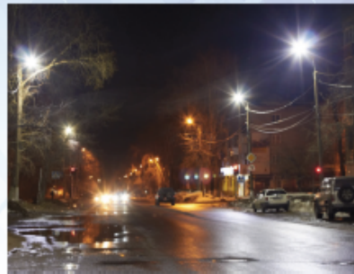
г. Комсомольск на амуре Освещение дороги
